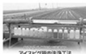
アイスビグ管内洗浄工法
