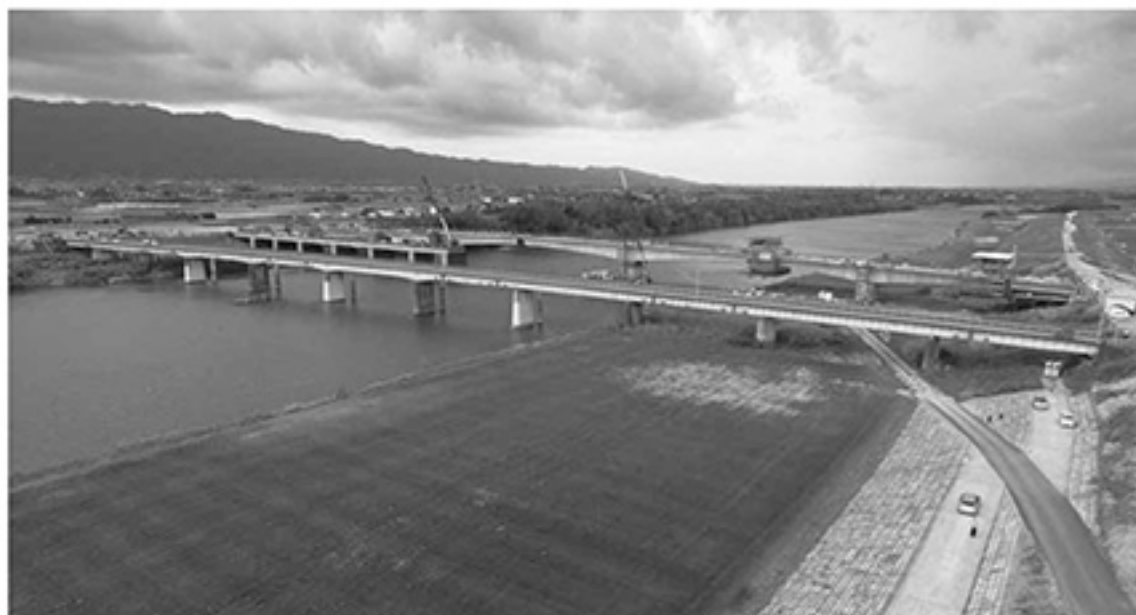
県道甘木田主丸線（西筑橋）
