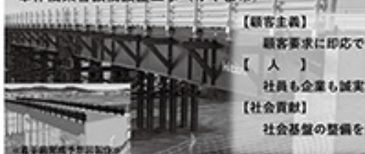
幸作橋架替仮橋設置工事（みやま市）
